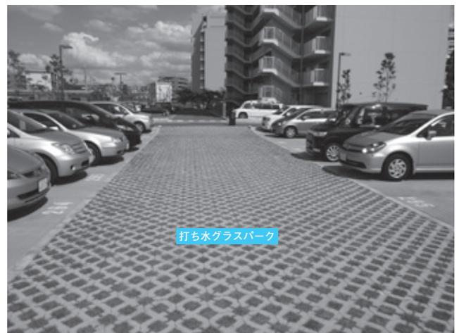
写真2 給水型緑化ブロック舗装「打ち水ガラスパーク®」の施工例(某集合住宅の駐車場、駐車スペースではなく車道を緑化している)
