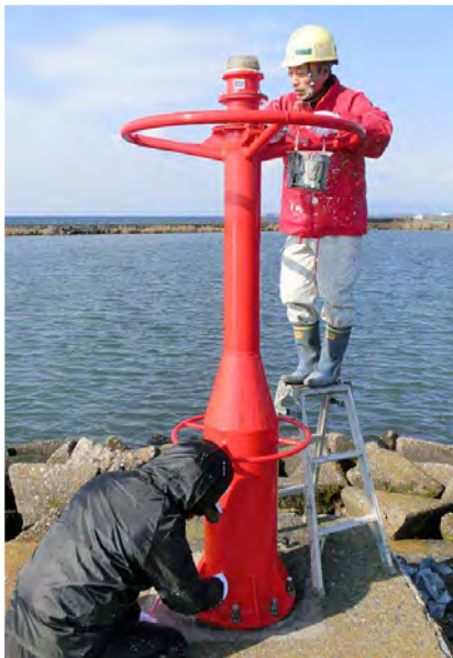
標識灯に塗料を施す作業員
