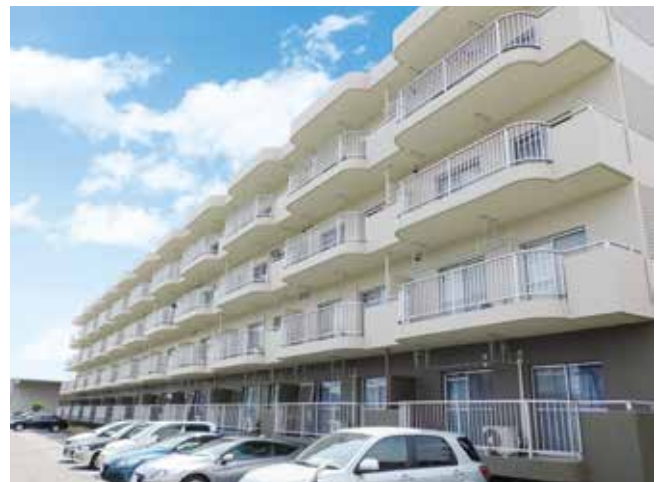
AGC(株)市原住宅 「ボンフロンGT WR-100SR工法」
