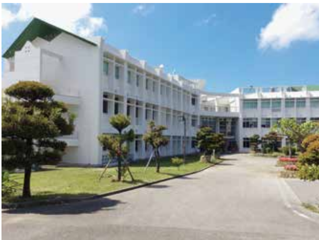
沖縄県立教育センター 「ボンフロンGT WR-100HBSR工法」
