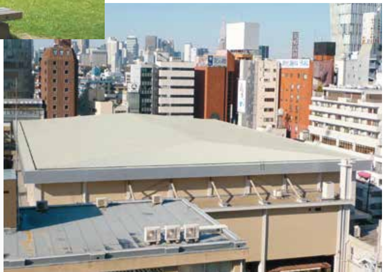
青山学院記念館 大学体育館(改修)
