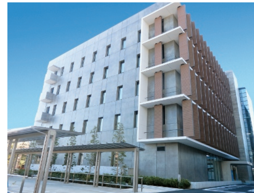
新座市役所 新庁舎
