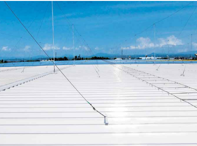
工場 折板屋根(2010年施工)
