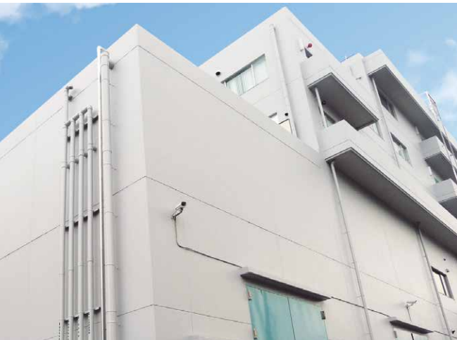
印刷工場 外壁(2011年施工)
