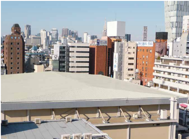
大学体育館 屋根(2010年施工)
